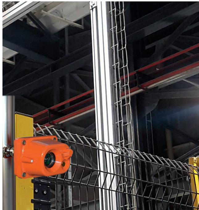
visual y auditiva. El MGD puede enviar estas señales de alarma temprana gracias a su conjunto de sensores electroquímicos. A través del análisis inteligente de varias combinaciones de distintos gases, el detector puede identificar un proceso de combustión en una etapa muy temprana.
